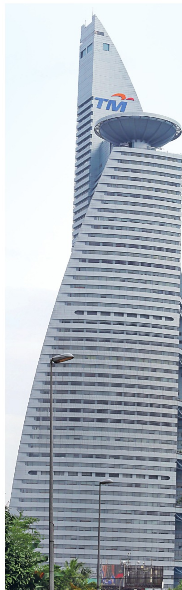
Menara TM at Jalan Pantai Baru KL
